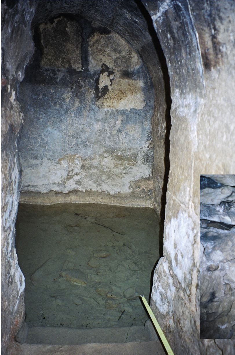
Arqueta para decantar las arenas y partículas sólidas
