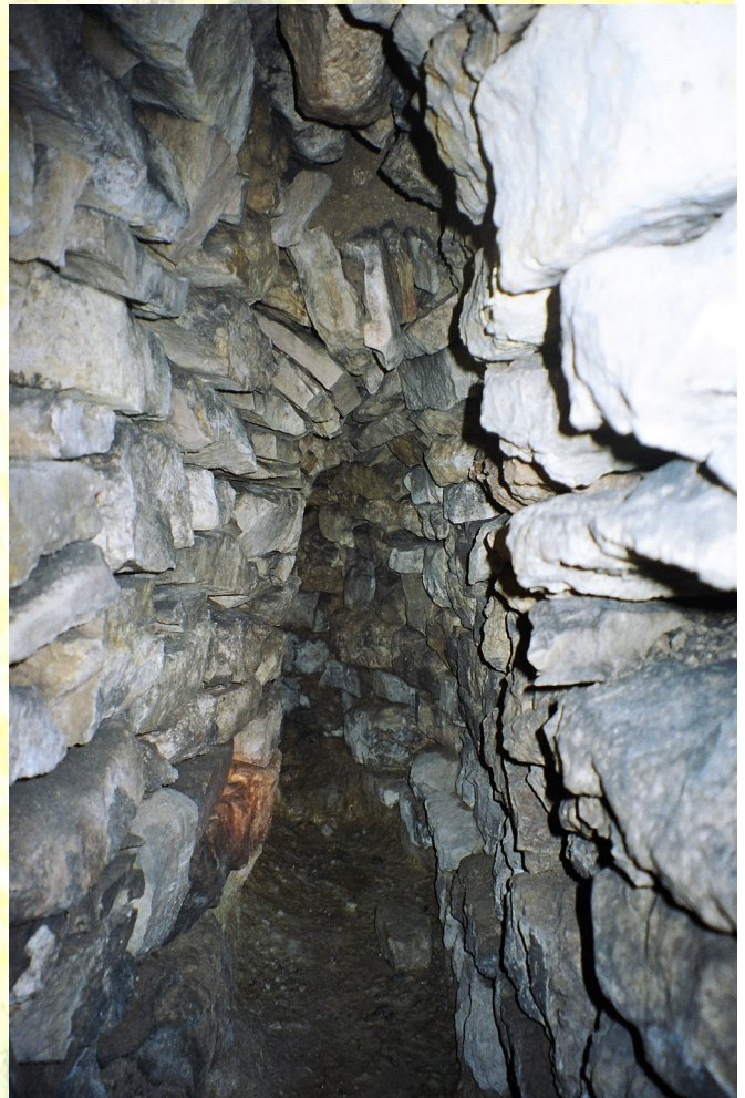
Galería secundaria que deriva en el arca de desarenado
